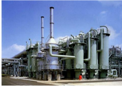
COG-SNG(石炭ガス化メタネーション)プラント
