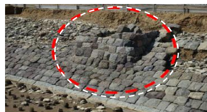
写真1 高輪遺構の信号機柱基礎
