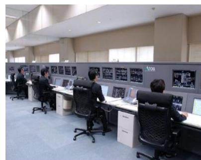
写真2 東京圏の輸送指令室
