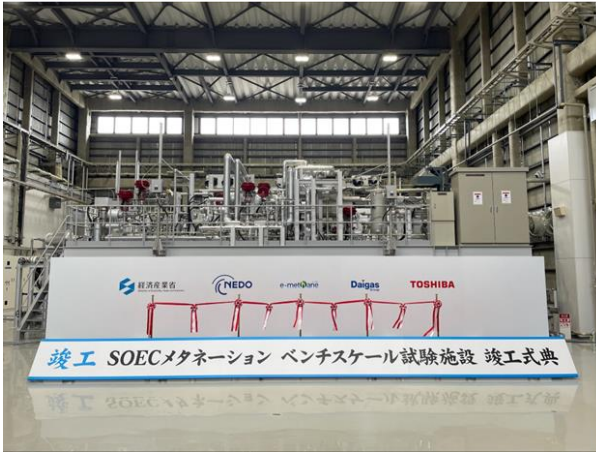
図7 SOEC メタネーションのベンチスケール試験装置
