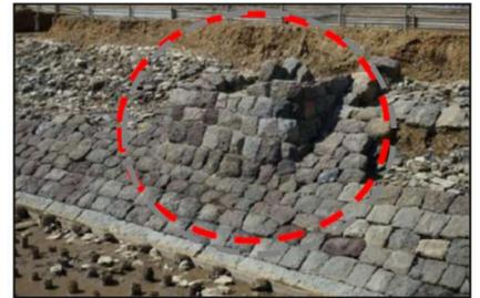
写真1 高輪遺構の信号機柱基礎
